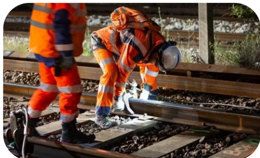
Ex: graissage d'un appareil de voie, remplacement d'une traverse mal placée
